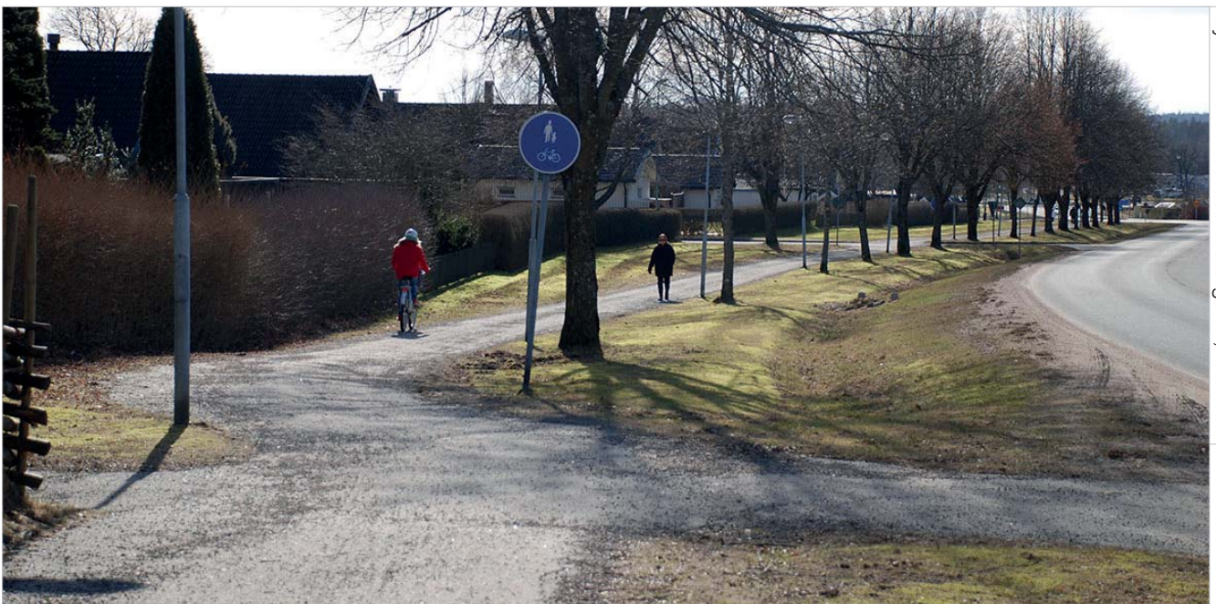
Cykelbana utmed Södra Storgatan, Gislaved
